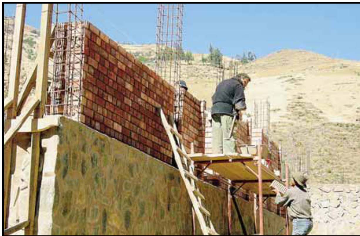
Silvio Tonelli al lavoro per la costruzione della chiesa di Pinra, che sarà inaugurata a primavera
