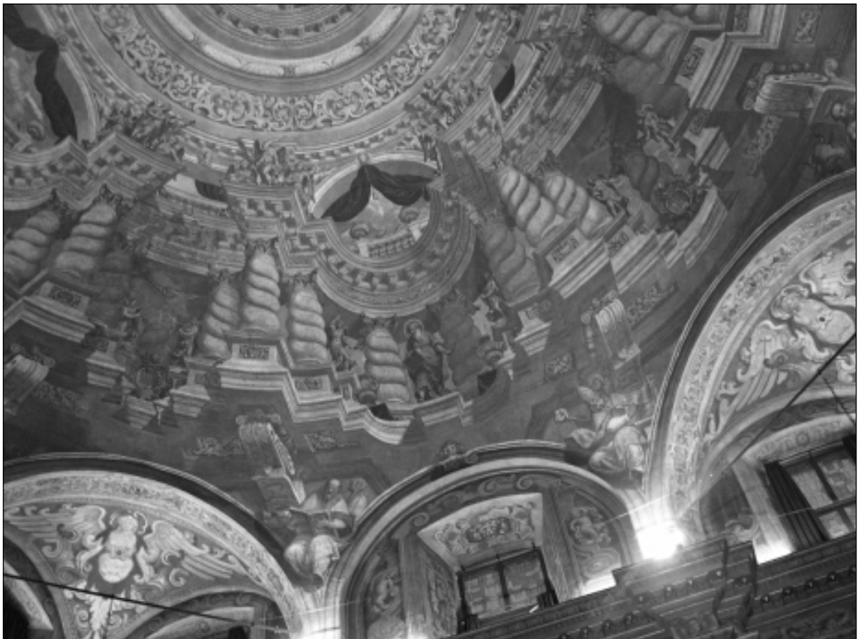
Particolare della volta della Basilica di S. M. Assunta
