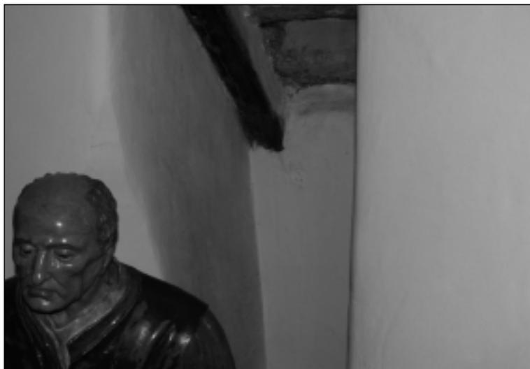
*Il passaggio murato dell'ingresso visto dall'interno della cappelletta, che mette in risalto l'intervento postumo per la costruzione della scala del matroneo. Le travi di sostegno rompono l'involto del piccolo tunnel.*
