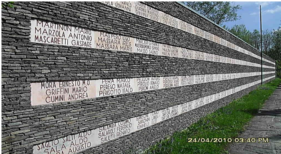
IL MURO DI FONDOTOCE
