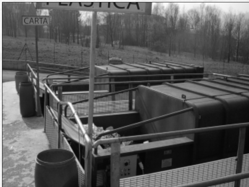
I compactori rimessi in funzione
