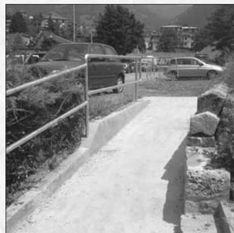
Parcheggio via Pascoli Nuovo passaggio pedonale
