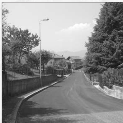
Via Fantoni Lavori di asfaltatura
