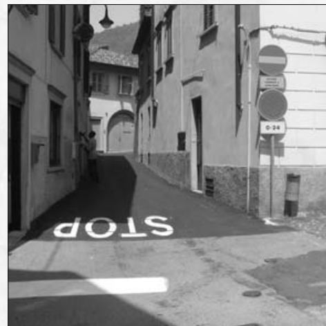
Via Giovanni da Gandino Lavori di asfaltatura
