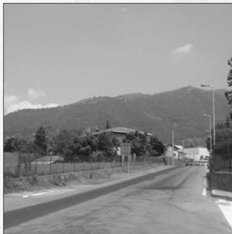
Via Provinciale Manutenzione e migliona reti distributive
