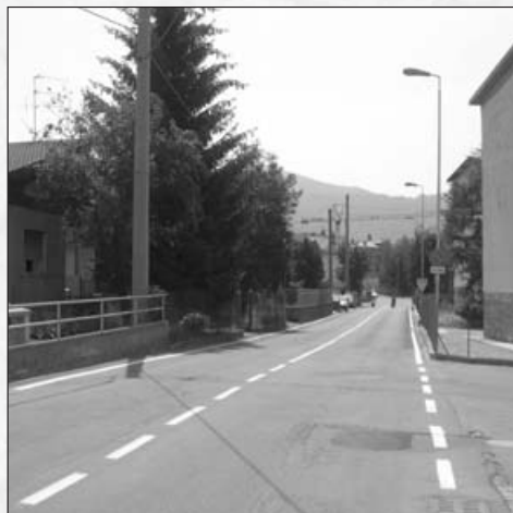
Via Nosari Lavori di asfaltatura
