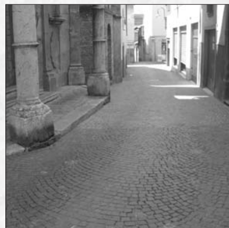
Via Suffragio Manutenzione straordinaria pavimentazione in porfido
