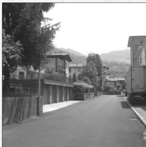
Via Aldo Moro Lavori di asfaltatura
