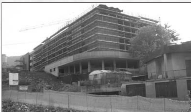
Abbattimento "ala viola" nel luglio 2001 (in alto) e cantiere attuale della nuova ala
