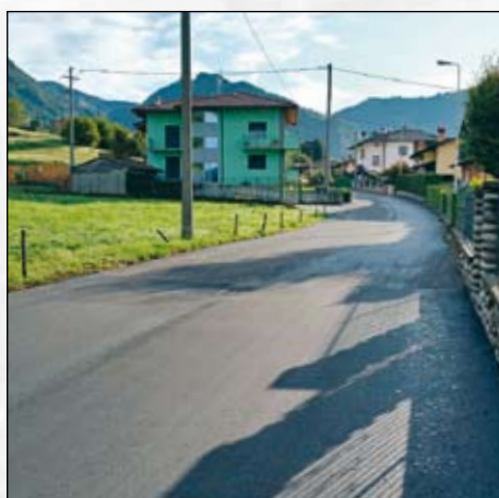
Asfaltatura Via degli Alpini e via Fantoni 39.000 euro
