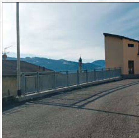
Rifacimento muro, nuova barriera - posa nuovo punto luce pubblica illuminazione (via Pascoli) - 14.114 euro
