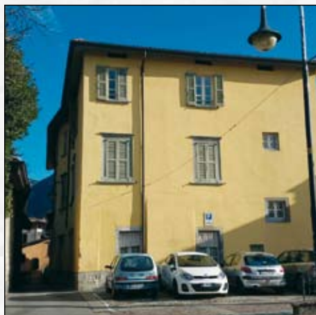
Riqualificazione tetto fabbricato con alloggi ed asilo nido in via Ghirardelli - 15.000 euro
