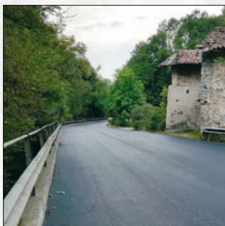
Asfaltatura Via Fondovalle 50.000 euro
