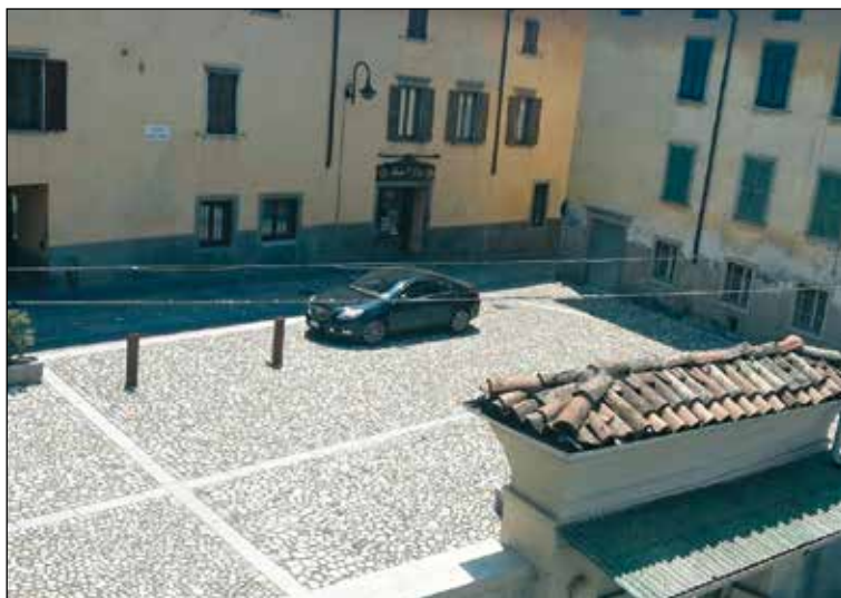
Uno scorcio della nuova pavimentazione di Piazza S. Croce, vista dall'alto
