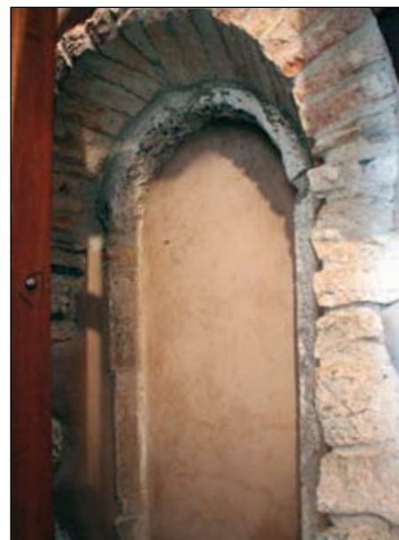
La finestrella a ogiva (murata), del '3 - '400 (seminascosta dal mantice) nella parete del locale sopra il Portichetto
